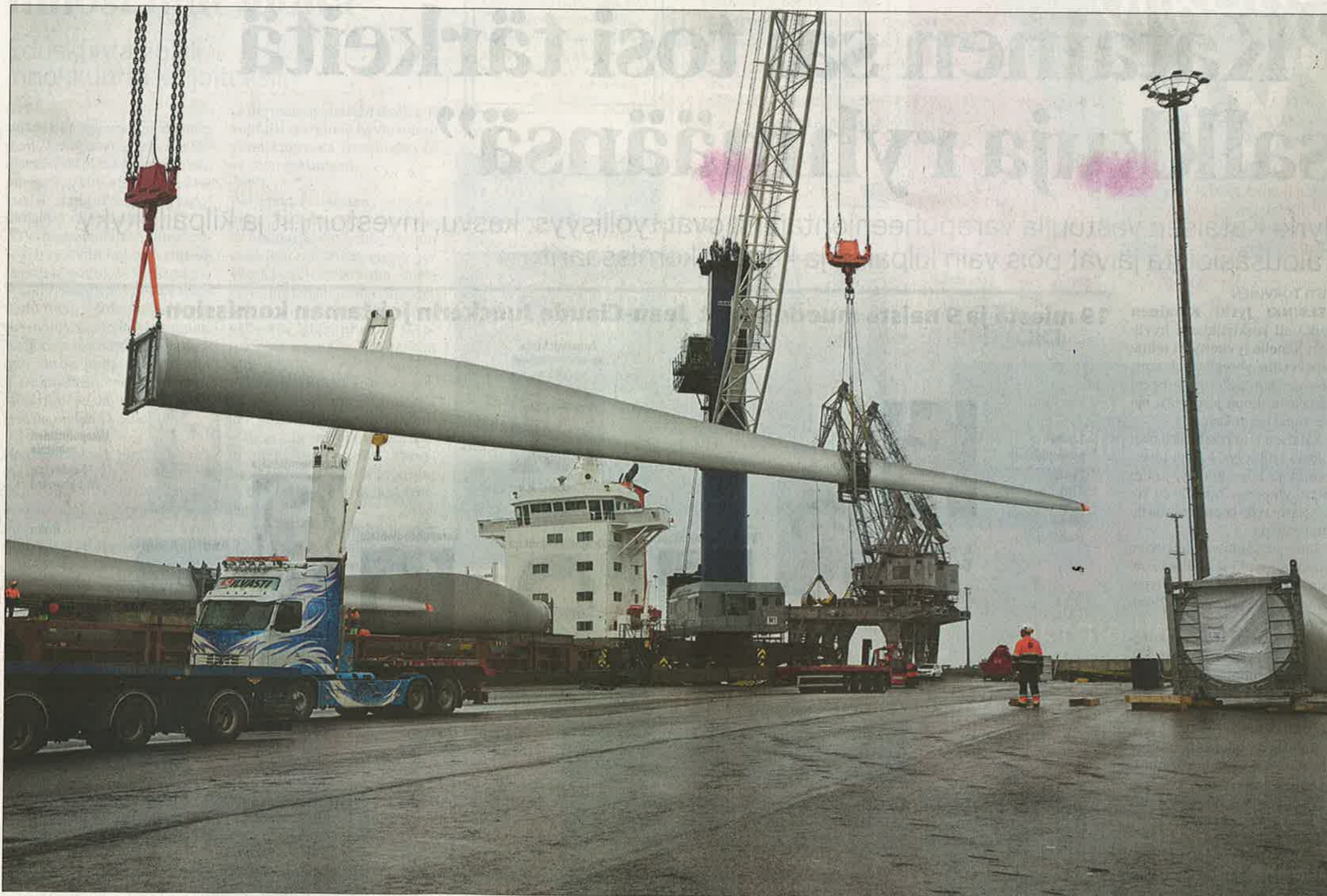
Tuulivoimalan siiven nostossa tarvitaan kahta nosturia. Sillä varmistetaan tasapainon säilyminen. KUVAT: TIMO ANNANPALO
