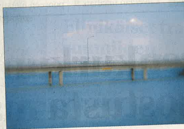
Merenkurkun sillasta on toistaiseksi vasta kuvitteellisia kuvia. Professori Antti Talvitie selvittäisi tarkasti sillan rakentamista.
